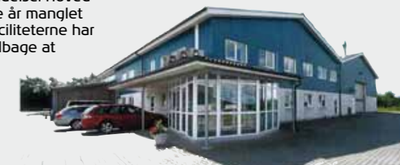
Den ny erhvervede ejendom, som maskinværkstedet i Uldum flytter ind i, har et samlet etageareal på over 3000 m 2 .
